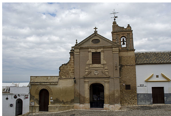
Fachada del convento de la Encarnación.
