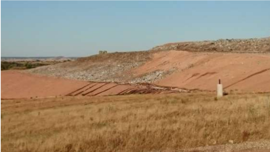
Filtraciones producidas por el riego de residuos
