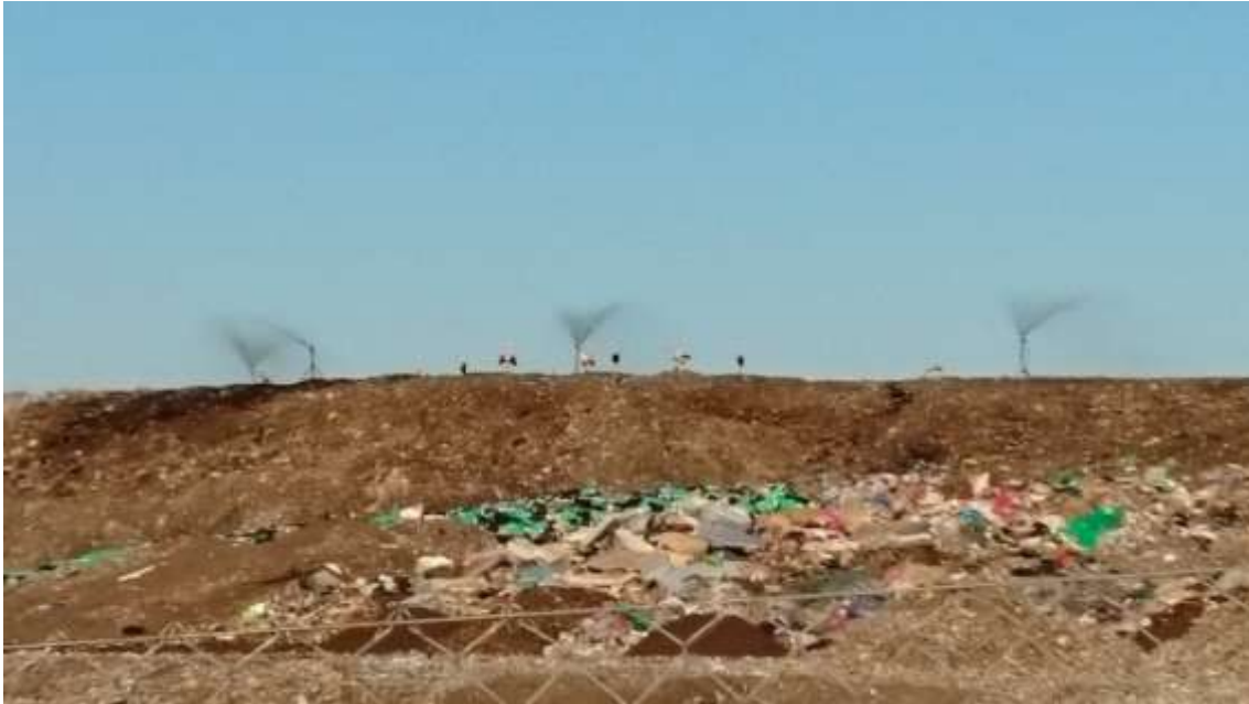
Riego de residuos en el vaso de rechazos
