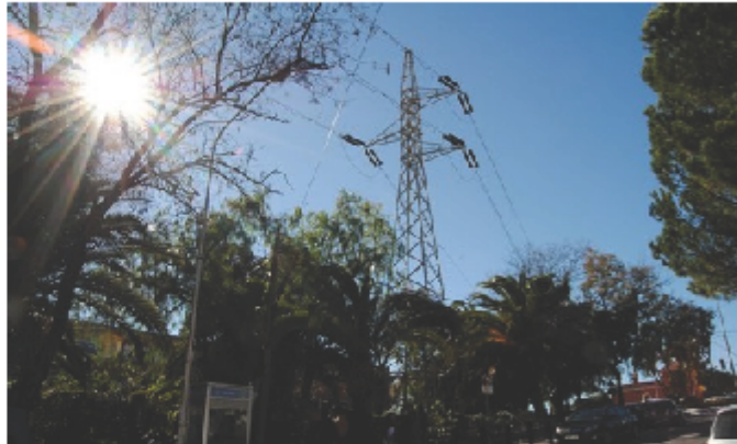
► Los cables que pasan cerca del colegio Al-Andalus.
