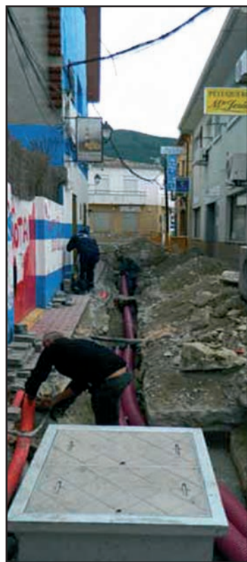
Obras de soterramiento
