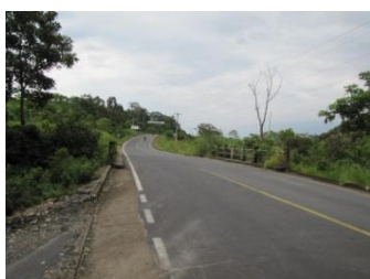
PUENTE RIO MONDAYACU
