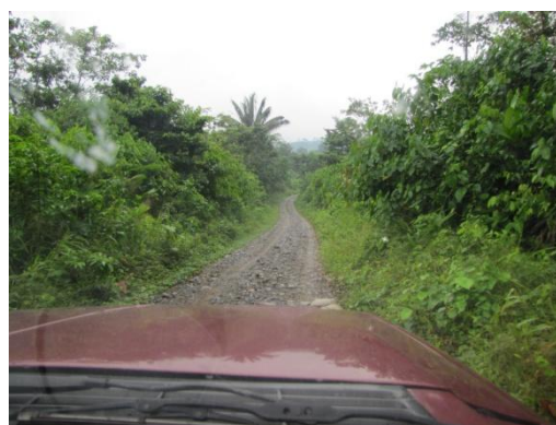
CAMINO VECINAL A NUEVA ESTRELLA
