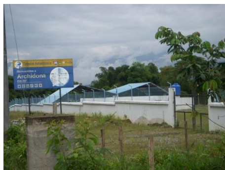
PLANTA DE TRATAMIENTO DE AGUA
